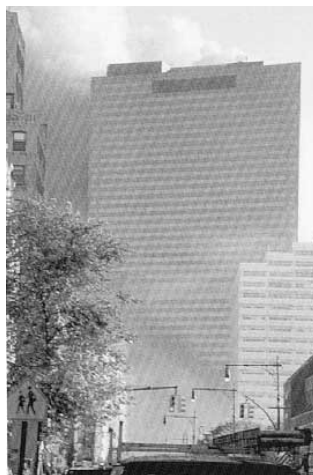
WTC-Gebäude 7 während des Einsturzes
